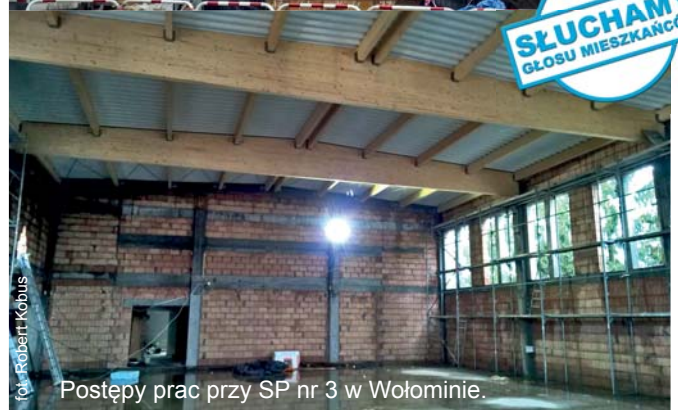
Postępy prac przy SP nr 3 w Wołominie.
